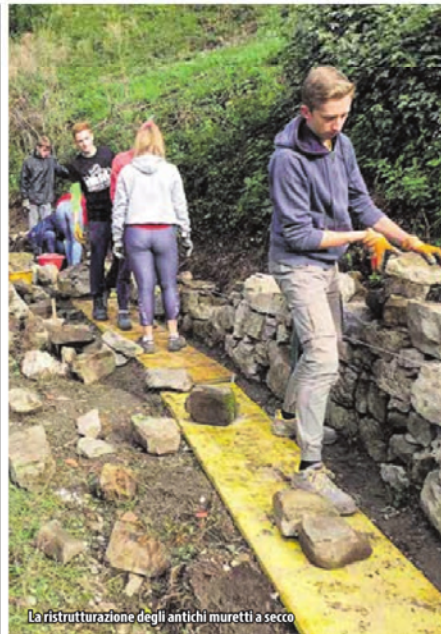
La ristrutturazione degli antichi muretti a secco
